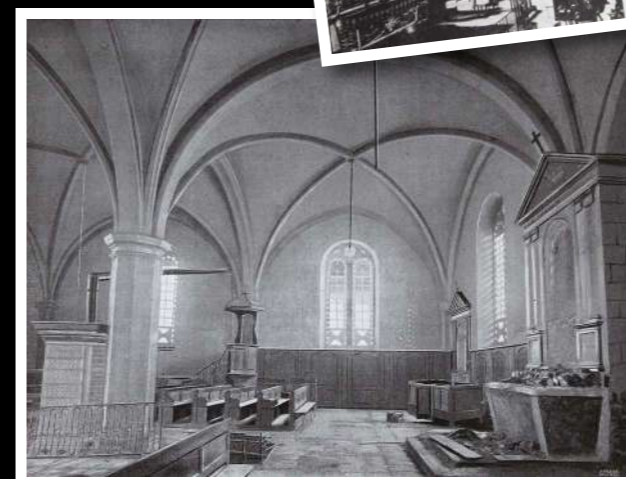
G / LA CHAPELLE en cours de démantèlement.
