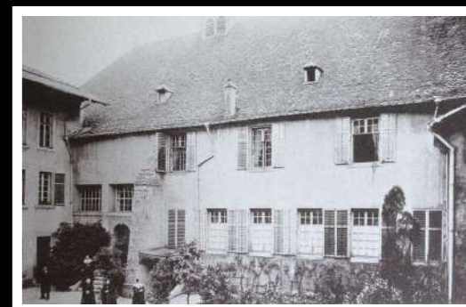
H / LA 1ÈRE COUR ; à gauche l'escalier de la Chapelle ; au R.C. le dortoir des femmes, au 1er les nouveaux dortoirs aménagés dans le grenier.
