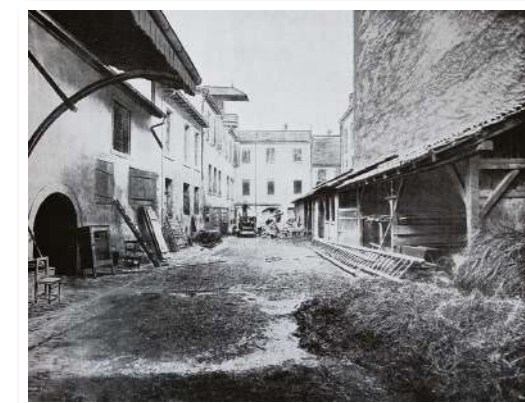
S / LA BASSE-COUR. À gauche le couloir vers la 2e cour, à droite, les maisons de la rue Saint Georges.
