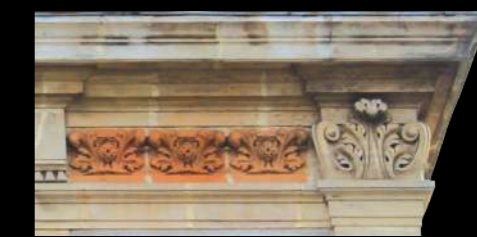
LA FRISE À MOTIF DE CHAPITEAUX, réalisée par l'architecte Weissenburger sur un modèle d'Ernest Bussière.
