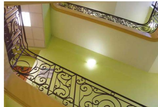
Escalier du bâtiment de l'horloge (actuel centre Spillmann).
